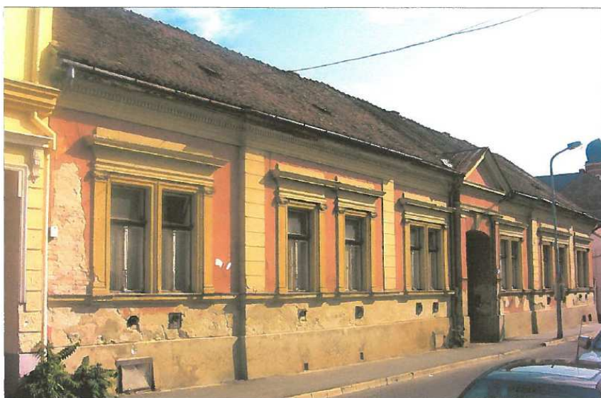
Ady Endre utca 6. nyugati homlokzata
